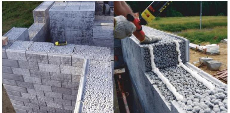
No se requiere ningún tratamiento adicional al finalizar el puesto de bloques. La superficie exterior de la pared se pinta por medio de una pistola de pintar o con otro método convencional. La parte interior de la pared no requiere ser estucada, se efectúa solo el plastecido con pintura o empapelado posterior
